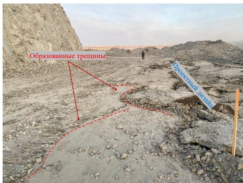
Рисунок 2.21 – Визуальная инспекция проектной бермы после взрыва контурного блока
